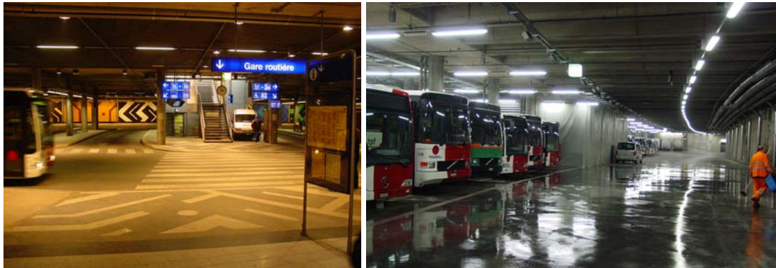
Abbildung 4-1: Busbahnhof mit unterirdischem Betriebshof in Fribourg (Schweiz) (links: Busbahnhof „Gare Routière“, aus der Sicht der Bahnstufunterführung, rechts: Betriebshof im Kellergeschoss)
