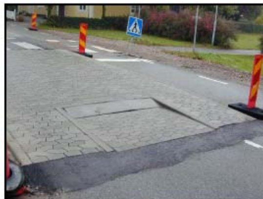
Abbildung 2-10: Fahrbahnaufpflasterung in H-Form als verkehrsberuhigendes Element (Lomma, Schweden)
