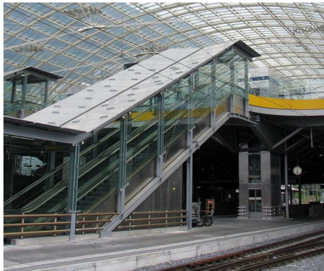
Abbildung 2-3: Umsteigestation zwischen Bahn und Bus in Chur (Schweiz)
