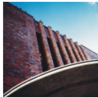
Die Bahnhöfe der Köln-Mindener Eisenbahn wurden zu Vorzeigeobjekten.
